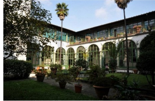
Erneuerung eines Gebäude-Heiz-Systems in Italien
