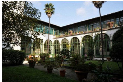
Modernizace topného systému budovy v Itálii
