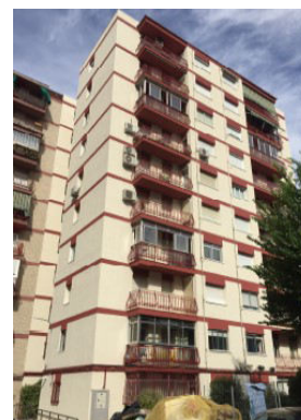
Nové zateplení budovy
