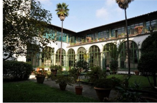
Izboljšanje ogrevalnega sistema stavbe v Italiji
